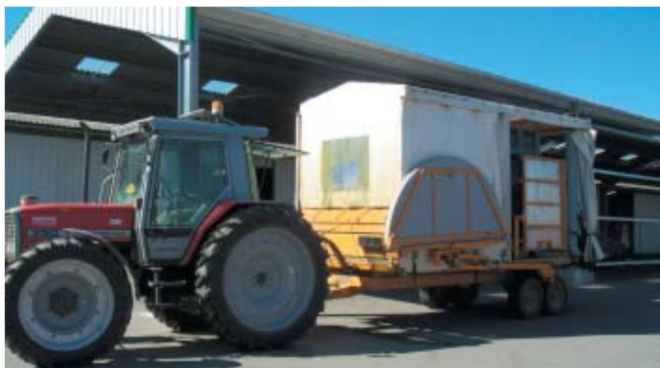
Un grand auvent à l'extérieur abrite un nouveau quai de réception. Non seulement les tracteurs ne pénètrent plus à l'intérieur (plus de salissure, de fumée), mais leur chargement reste aussi à l'abri en attente d'être déchargé.
